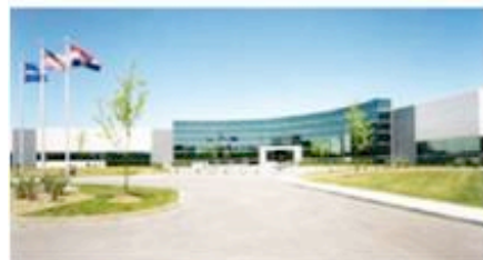
Edificio de oficinas, gobierno del estado de Hidalgo 2007.
